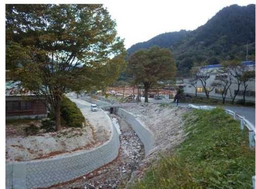
堆積土砂 浚渫完了
