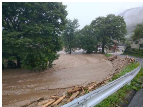
土砂流入箇所
