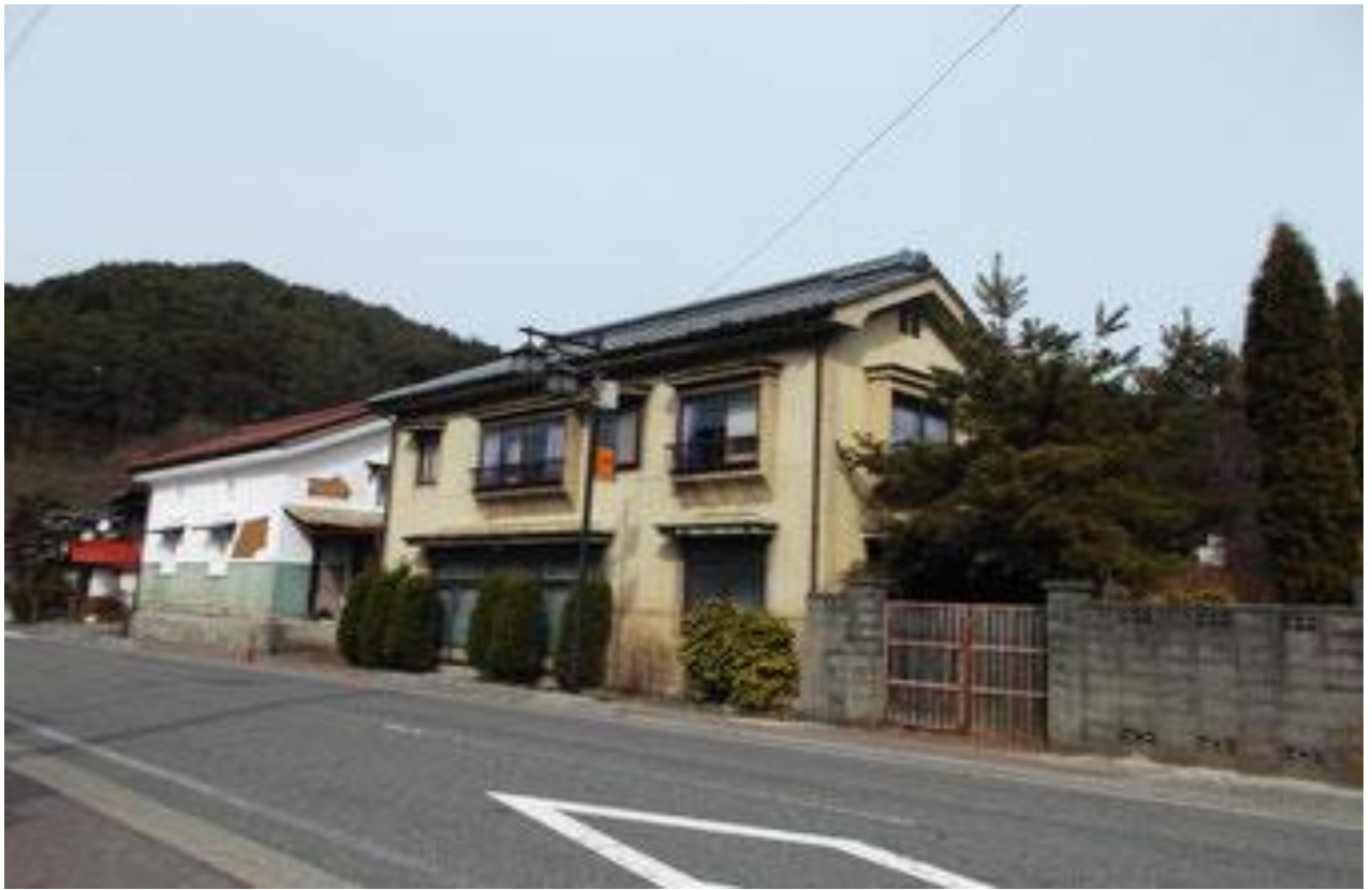
外観①（店舗兼居宅）
