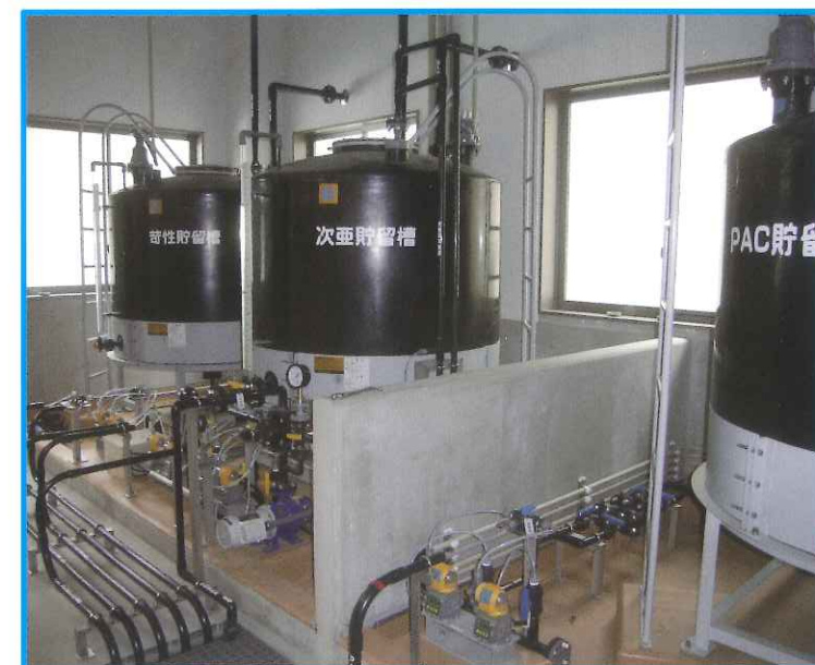
③薬品注入室
