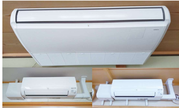
エアコンの整備 3 台 (大広間・台所・和室)
