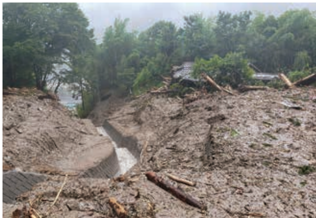
○宮戸沢の土石流発生による被災状況
