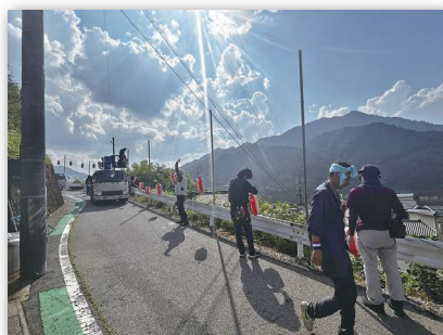
暑い中、寺坂に提灯を設置している 上松町建設協会の皆様
