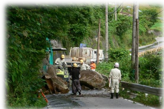
孤立を解消するための道路啓開
