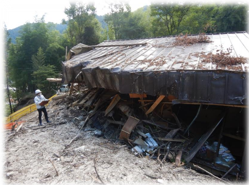
令和3年8月豪雨災害 被災家屋調査 (宮戸地区)
