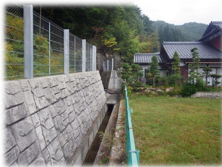
長野県急傾斜地崩壊対策事業 (小脇地区)
