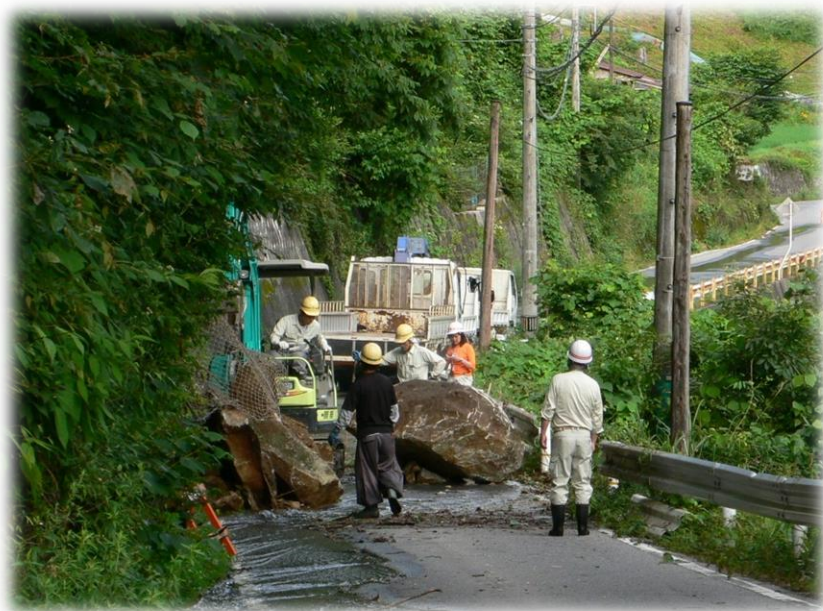
台風後の落石除去による道路の啓開
