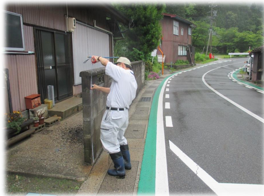
ブロック塀の点検作業
