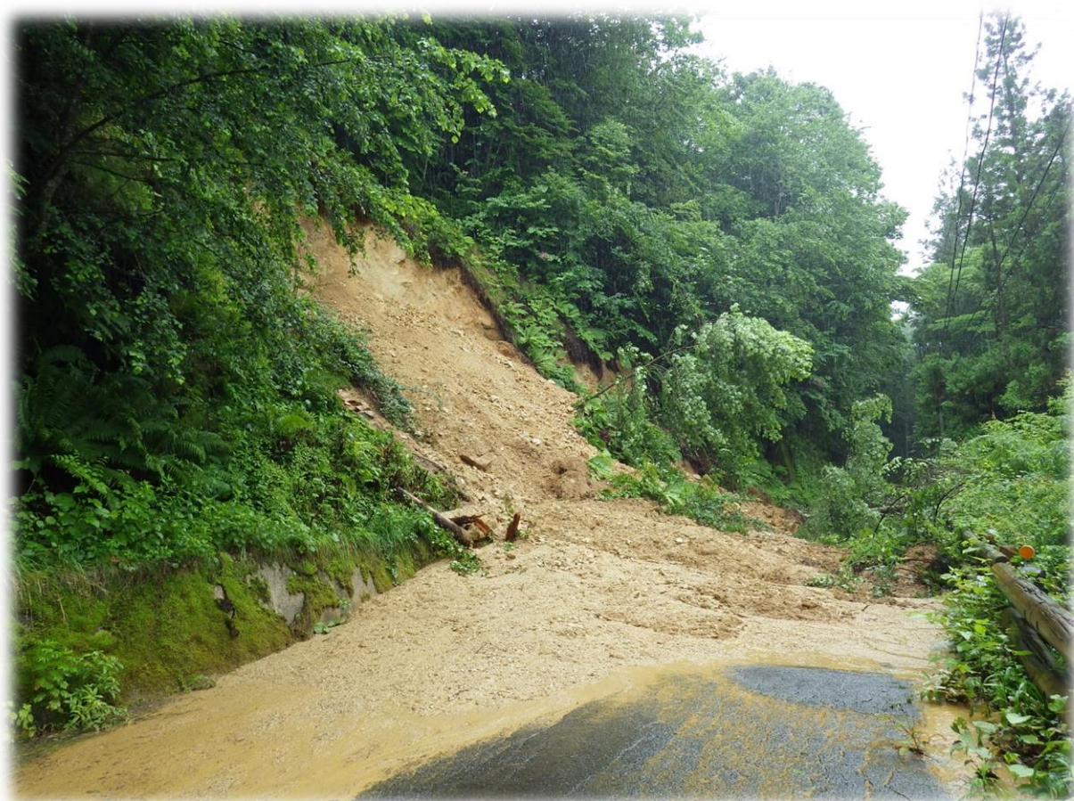
令和2年7月災害 土砂崩落により通行不能となった町道赤沢線
