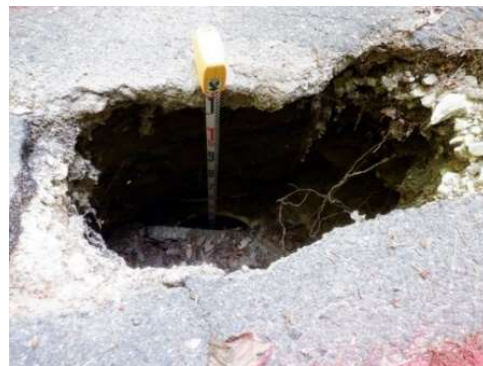
路面に空いた深さ1.1mの穴と道路巾約半分が谷側に沈下
