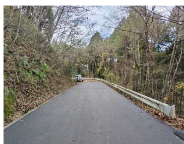
勾配を付け直して再舗装
