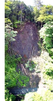
林道沿線斜面の崩壊
