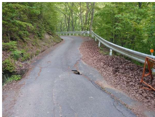
路面に空いた深さ1.1mの穴と道路巾約半分が谷側に沈下
