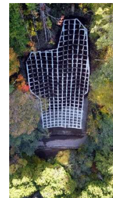
国庫補助：法枠施工 譲与税：枠内緑化
