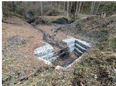
堆積していた土石を撤去し、目詰まりしづらいうように擁壁を設置
