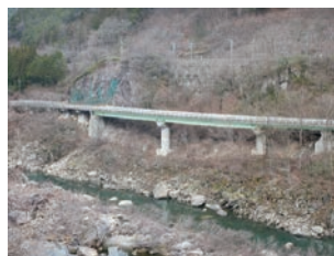
長寿命化を図る長坂栈道橋
