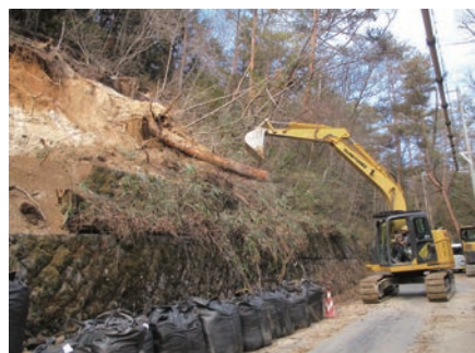
町道高山線法面崩落応急対策工事
