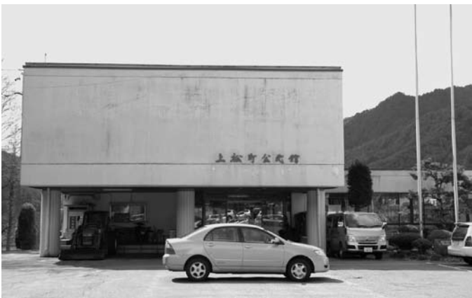
耐震化等の改修が行われる公民館
